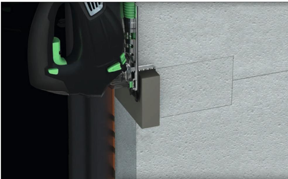
Al poder cortar el EJOT® Iso-Corner a la medida deseada una vez colocado el SATE, permite una instalación sencilla y enrasada con el aislamiento.
