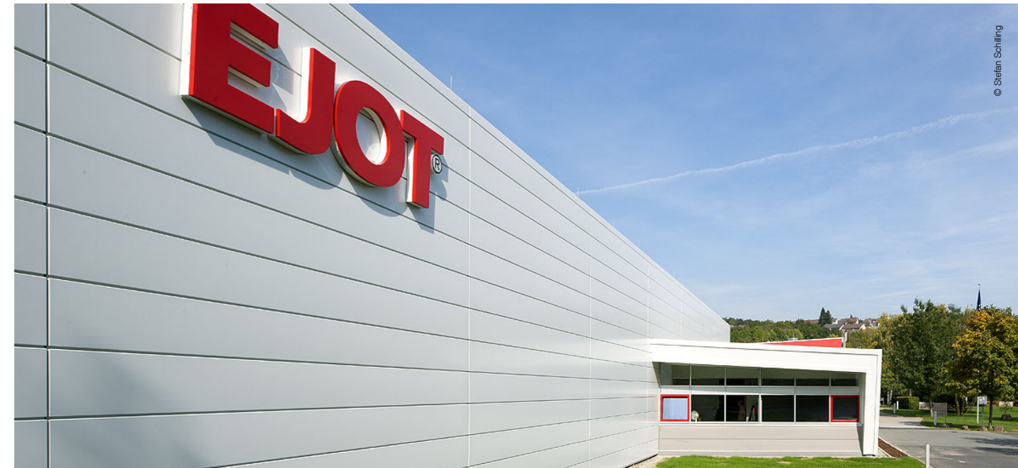
Fábrica de tornillos bimetálicos Planta de "In der Aue" en Bad Laasphe, Alemania.
