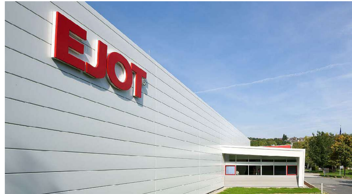
Fábrica de tornillos bimetálicos - Planta de „In der Aue“ en Bad Laasphe, Alemania
